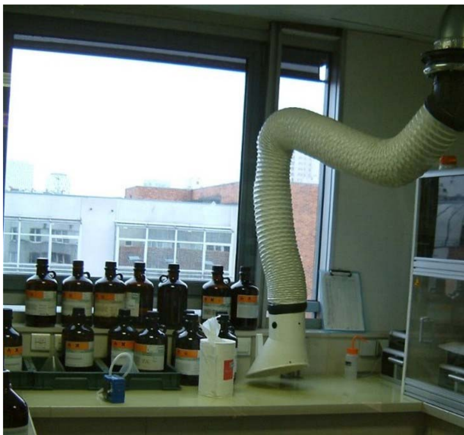
Photo 3 : Cobra utilisé pour le rassemblement des réactifs.
